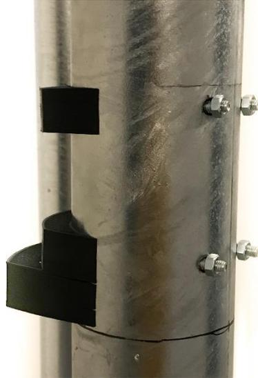
Abbildung 43: Bohrungen im Mast
